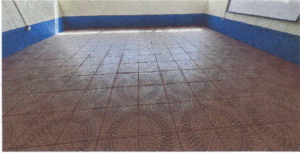
Foto1: Sustitución de torta de cemento por piso cerámica
