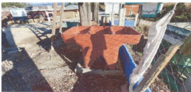
Foto 5: sustitucion de pila de plástico de dos lavaderos
