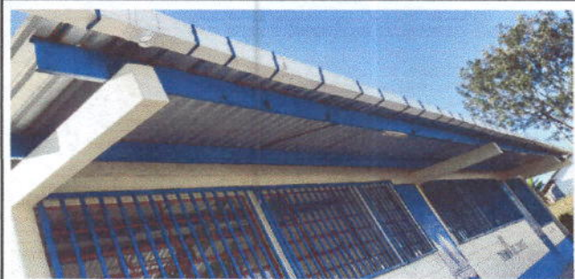
Foto 6: Sustitución de vidrios, balcones, y canal para bajada de agua
