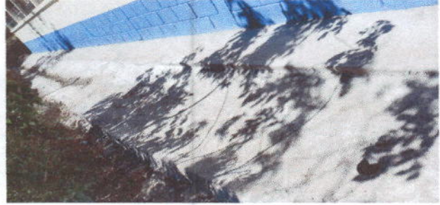
Foto 2: Reparación de cuneta de concreto y banqueta de concreto
