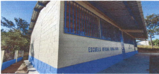
Foto 3: pintura en muros exteriores
