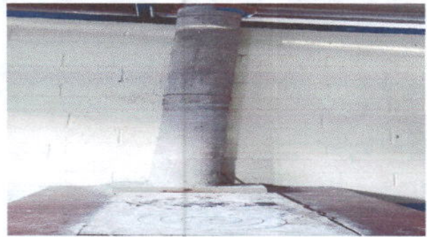
Foto 4: sustitución de chimenea de concreto
